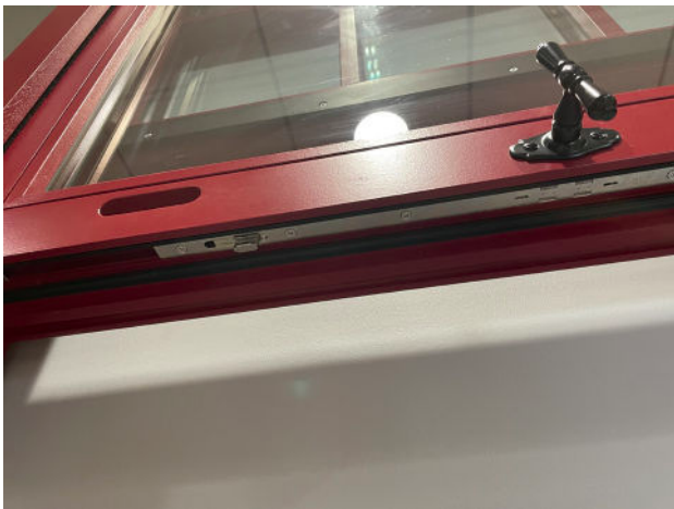
Double joint sous ouvrant pour une meilleure étanchéité en partie basse
