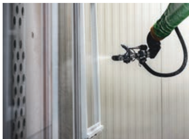
Après le traitement Insecticide Fongicide Hydrofuge, nous appliquons un fond dur pour protéger votre menuiserie
