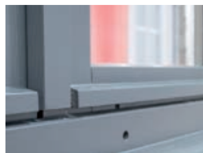
Jet d'eau pente à 15° (ou carré)
